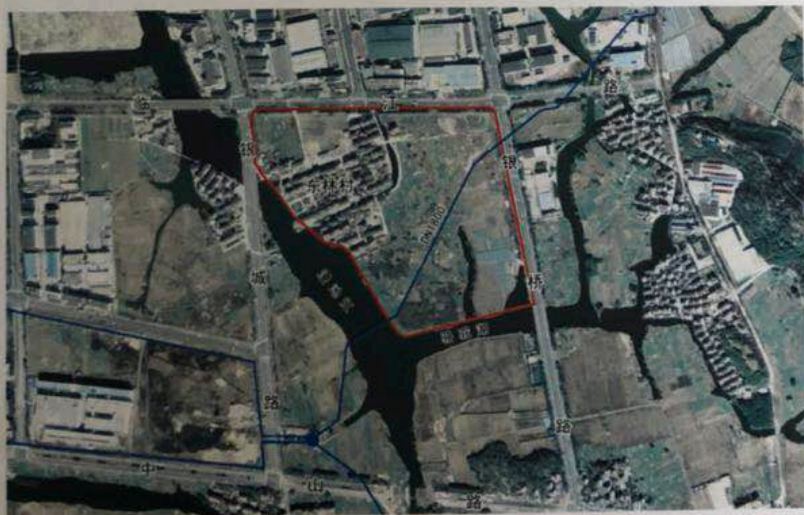
图 3：地块内建设情况现状图
